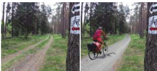
Ryc. 15 Przykładowe dostosowanie istniejącej drogi leśnej - utwardzenie kruszywem (Typ 4a)
