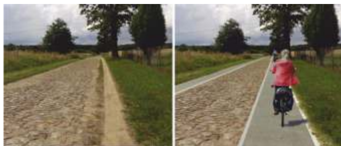
Ryc. 18 Przykładowa zmiana organizacji istniejącego układu drogowego - ciąg rowerowy przy drodze z brukowca (Typ 3b)
