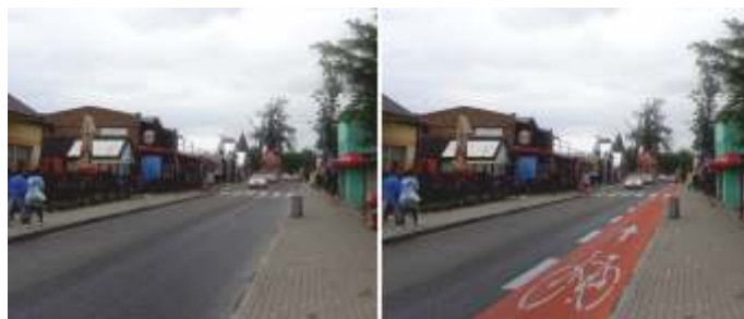
Ryc. 13 Przykładowa zmiana organizacji istniejącego układu drogowego - pas rowerowy w obrębie jezdni (Typ 1a)
